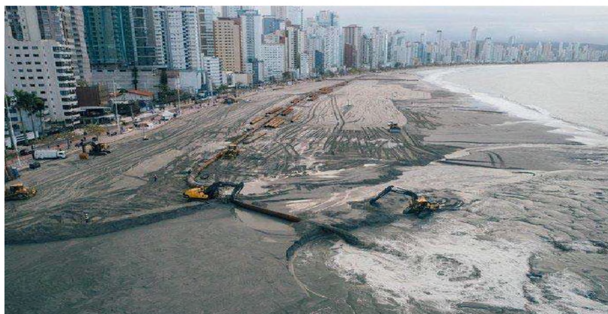
Figura 9 - Praia Central de Balneário Camboriú, durante as obras de engorda artificial em 2021
