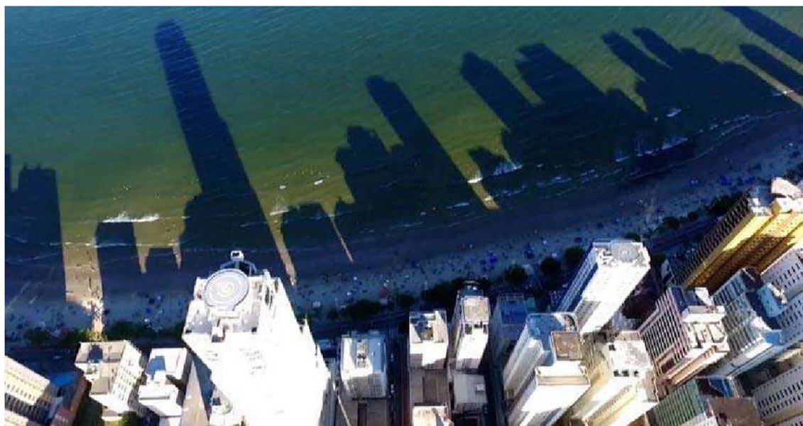
Figura 5 - Sombreamento na praia causada pelos altos prédios construídos na beira-mar antes da obra de alargamento
