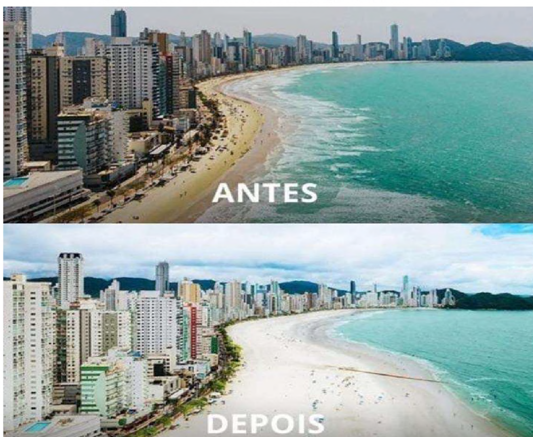
Figura 8 - Antes e depois da obra de engorda artificial de BC
