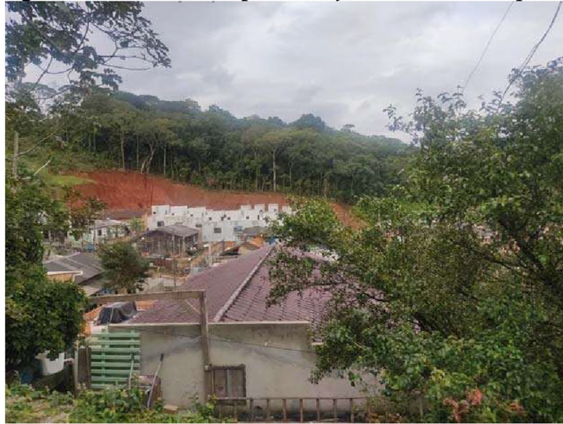
Figura 6 - Erosão causada por habitações em local inadequado.
