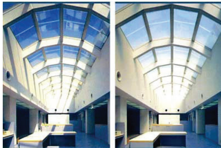
Figura 12 – Exemplo de smart windows utilizadas como teto e variando de opacidade com eletricidade Fonte: http://www.mundoarquitectura.org/cristal-electrocrmico-un-gran-avance-en-el-ahorro-de-energia/
