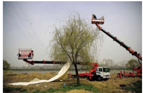
Figura 19: Foto da execução do trabalho.
