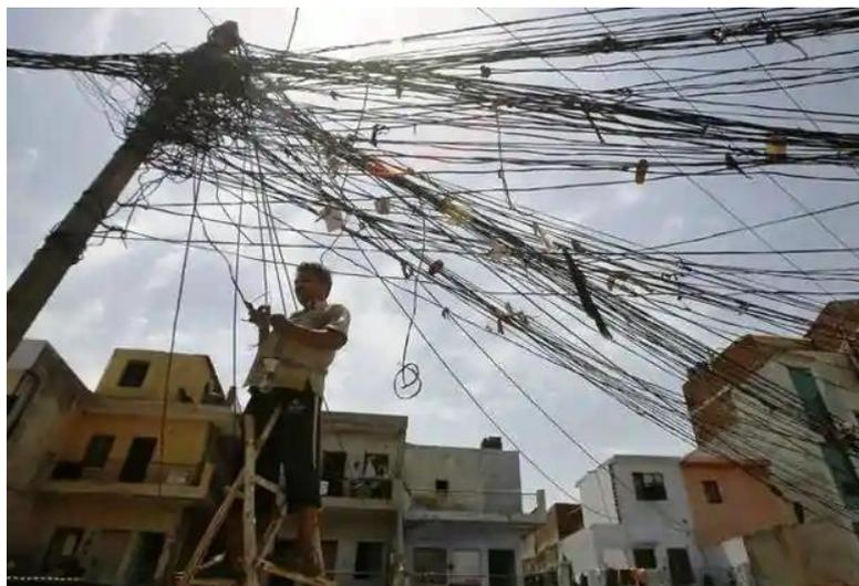
*Figura 6 – Instalação de Ligação Clandestina de Energia.*
