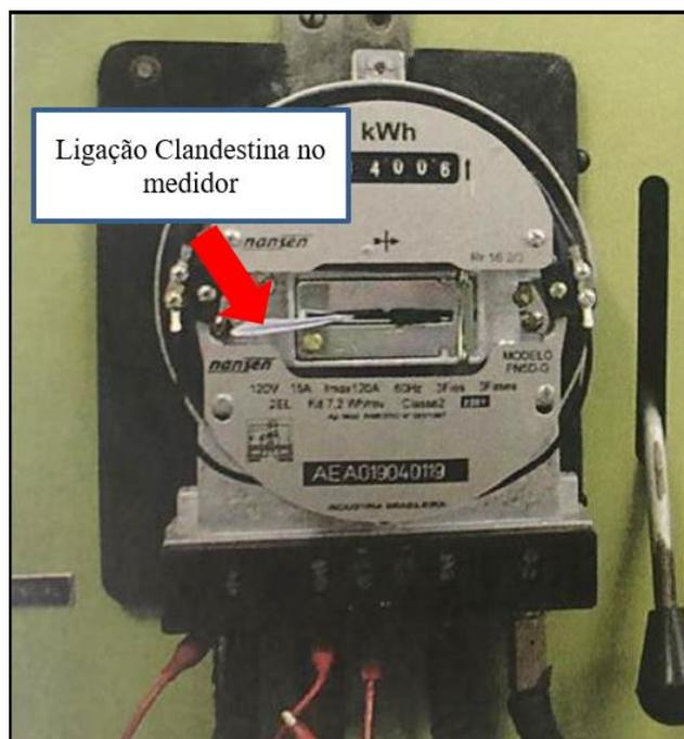
*Figura 22 – Tipo de ligação clandestina no medidor*
