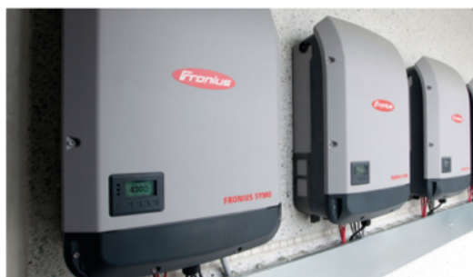
Figura 3.21: Modelos de inversores aplicados em SFI e aplicados em SFCR. Fonte: autoral.
