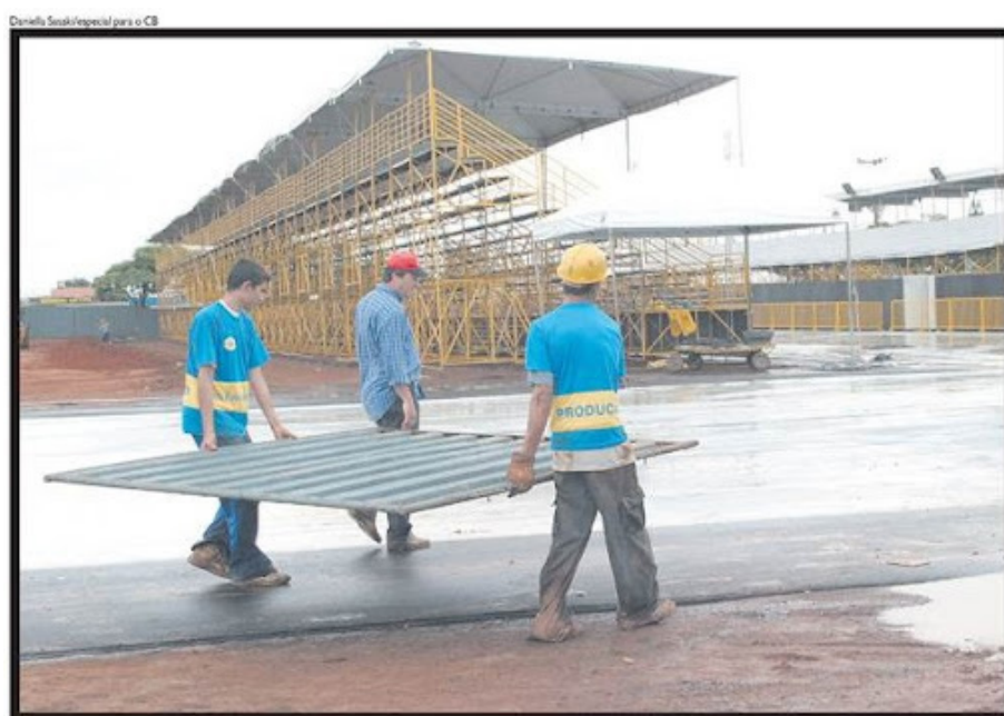
OPERÁRIOS TRABALHAM PARA TERMINAR A ÁREA DOS DESFILES, NA CEILÂNDIA: ARQUIBANCADAS COBERTAS TÊM CAPACIDADE PARA 12 MIL PESSOAS SENTADAS
