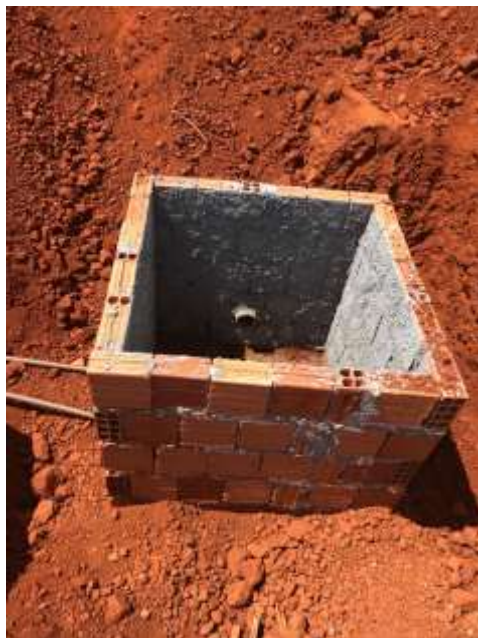
5) Construção da caixa em si.
