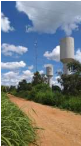
14) Caixas de água feitas pela caesb, mas não fornece água, por falta de pagamento
