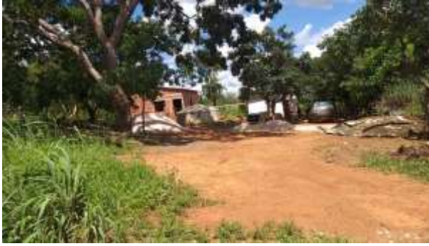
13) Foto mostrando uma chácara com uma construção de uma casa de alvenaria e uma caixa de água de alvenaria também
