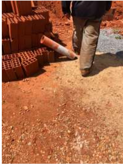
4) Preparando as caixas para armazenamento da água
