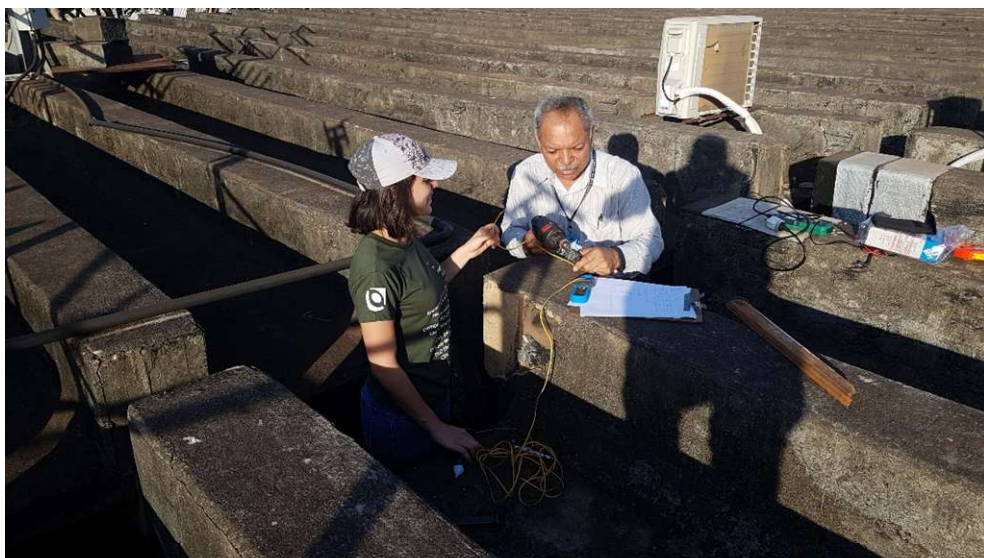
Figura 5.1 - Teste realizado com armadura das vigas da laje superior do SG-11.
