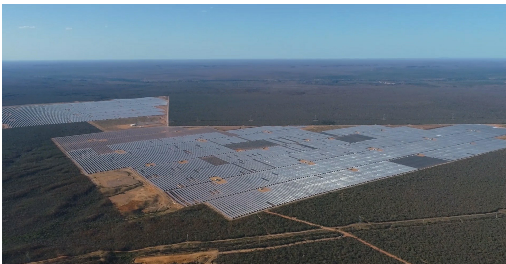
Figura 2.5: Usina solar em São Gonçalo do Gurguéia-PI (Fonte: Governo do Estado do Piauí)
