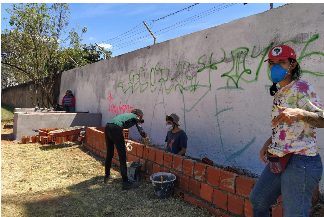
Figura 12 – Construção de canteiro baixo
