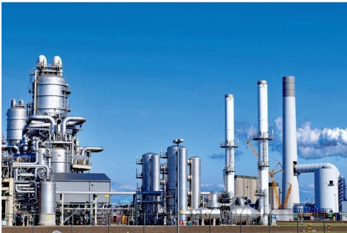
Figura 6-3 – Complexo Industrial da mineradora Itafós na porção norte próximo à subárea IV. Coordenadas da mineradora: 310829m E e 8657348m S. Datum Sirgas 2000, Zona 23S.
