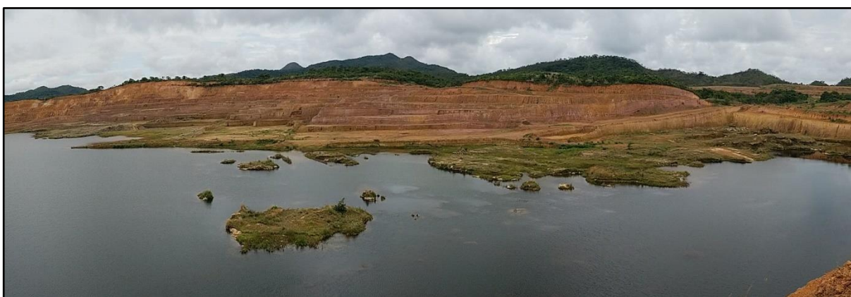
Figura 6-6 – Foto da barragem tirada pela equipe IV do Projeto Campos Belos (GO) na mineradora desativada pela Itafós. Notar a localização e os rejeitos de siltitos que são colocados na cava na mesma sequência em que foram retirados. Ao fundo as Serras Gerais e os morros de dolomitos à direita. Localização da desta foto: 309716m L e 8569253m S Datum Sirgas 2000, Zona 23S.
