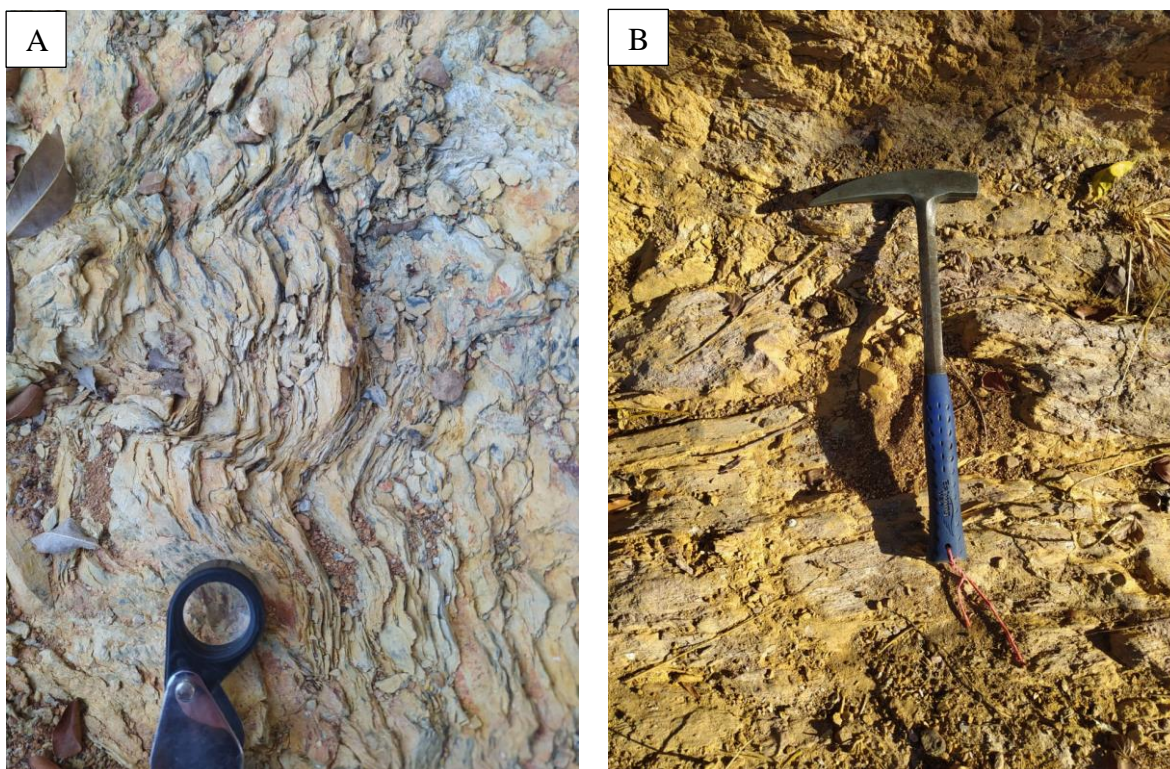
Figura 4. 17- A) Siltito laminado alterado em vala de erosão. B) Siltito laminado alterado de cor rosada na estrada.
