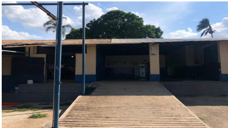
FIGURA 14: Faixada do galpão principal. Fonte: Hospital Veterinário de Grandes Animais-UnB.
