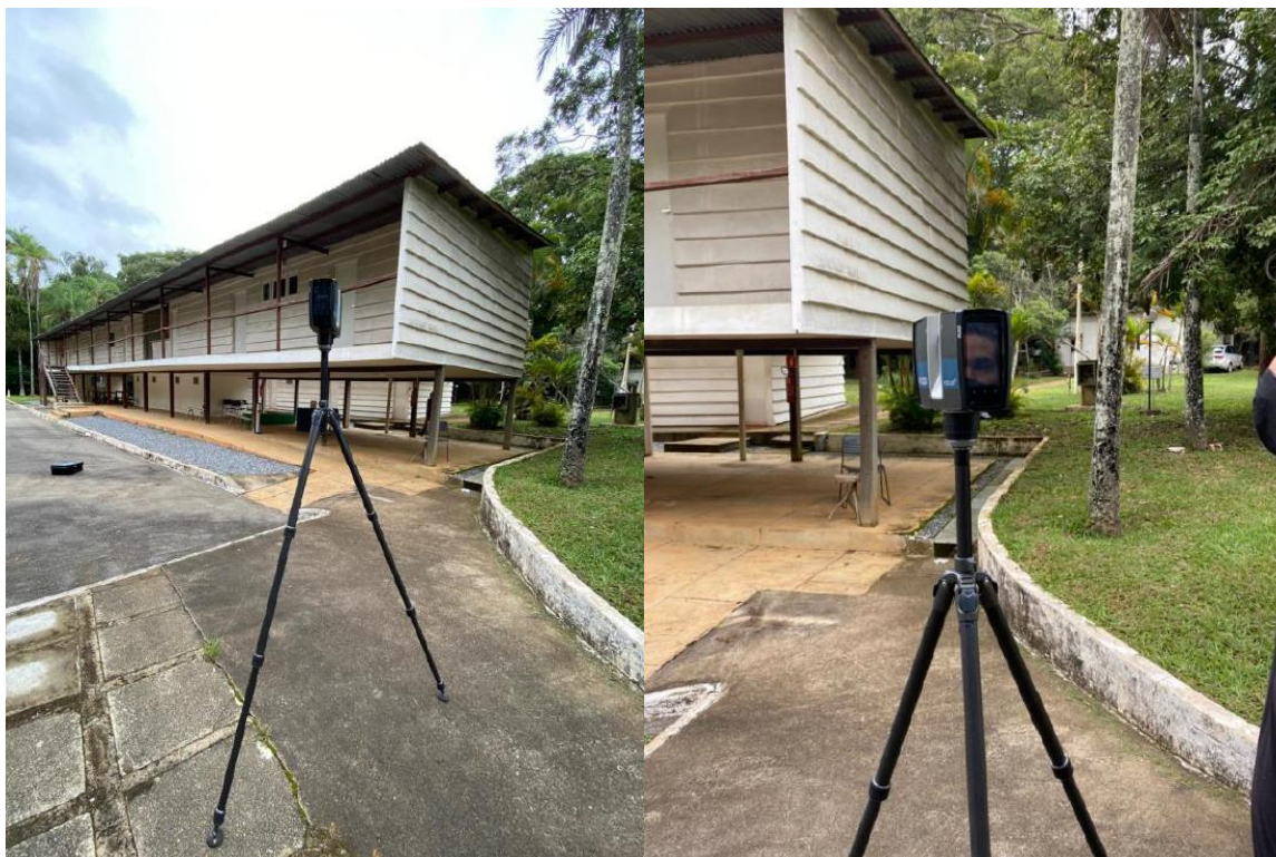
Figura 3.2 Aparelho de escaneamento a laser FARO Focus M 70 utilizado para modelagem as built do Catetinho, em Brasília. Fonte: ALMEIDA, 2021, p. 45.
