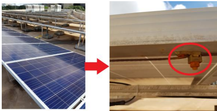
Figura 3.12: Equipotencialização do arranjo fotovoltaico
