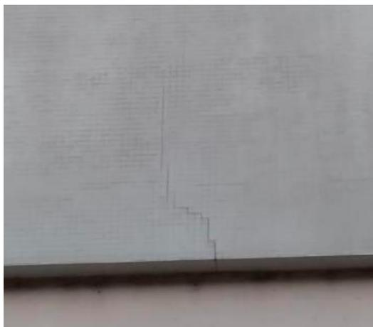
Figura 7 – Fissura em sistema de revestimento cerâmico de fachada (Delazeri, 2018)
