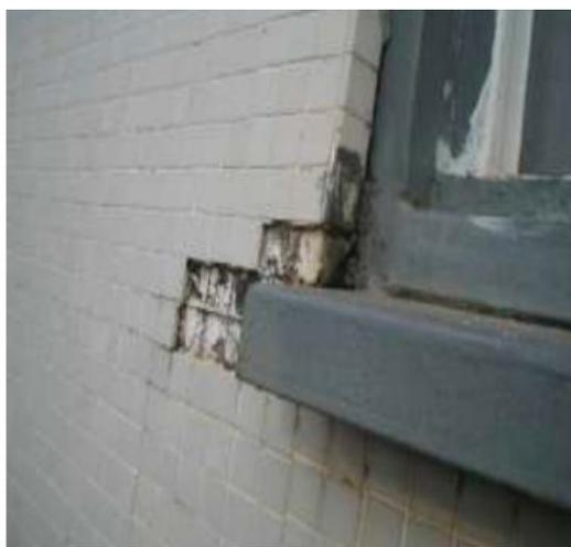
Figura 10 – Falha de rejunte (Silva *et al.*, 2014).
