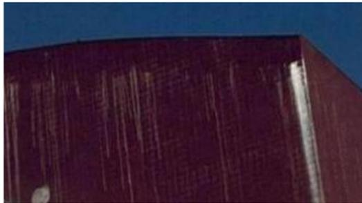
Figura 6 – Eflorescência em sistema de revestimento cerâmico (Bauer, 2010).
