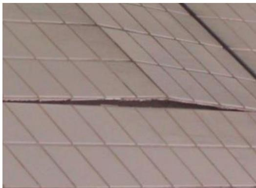
Figura 4 – Descolamento Cerâmico (Bauer, 2010)
