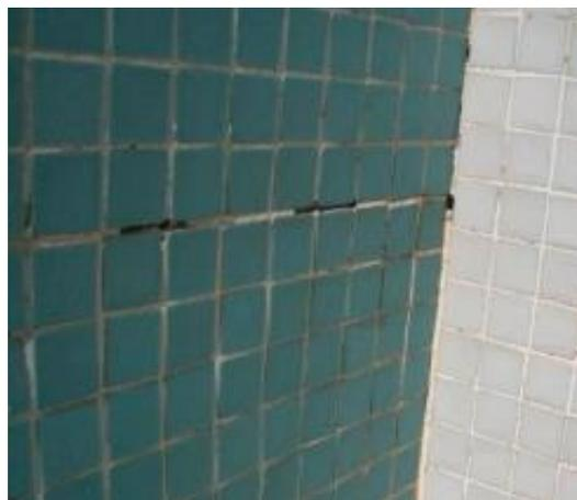
Figura 9 – Falha de rejunte (Silva, 2014).
