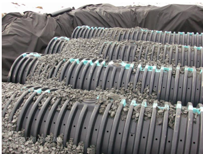
Figura 3.19 Reservatório de detenção subterrâneo (Philadelphia Water, 2014)
