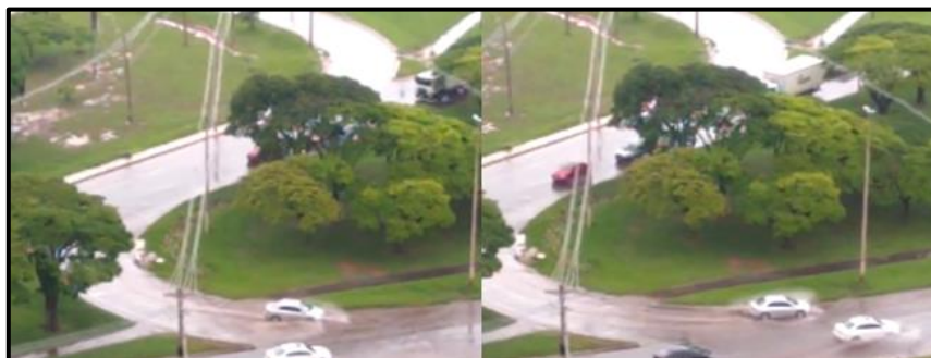
Figura 4.16 Registro fotográfico da rotatória após chuva de baixa intensidade
