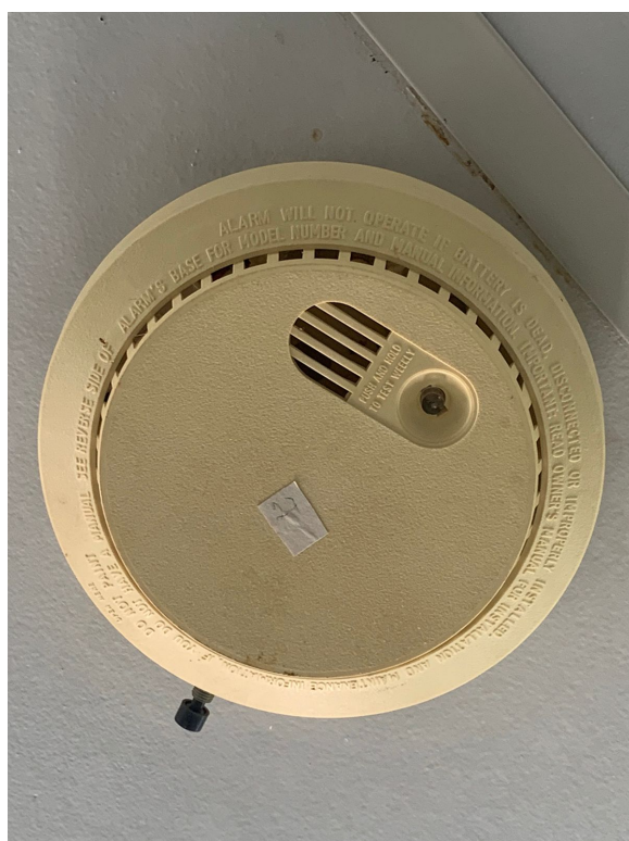
Figura 44 – Detector de fumaça
