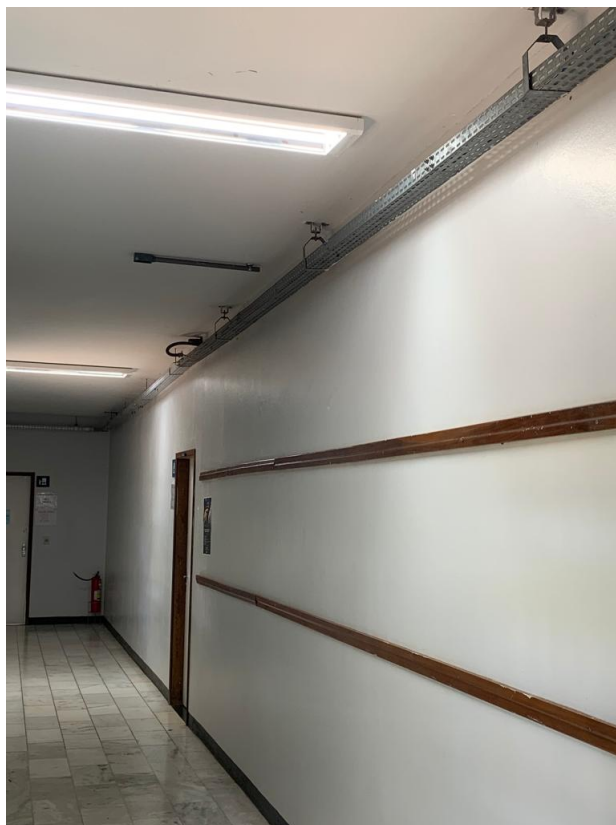
Figura 52 – Eletrocalha FE5
