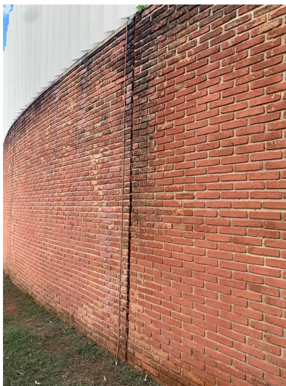
Figura 39 – Descida do para-raio
