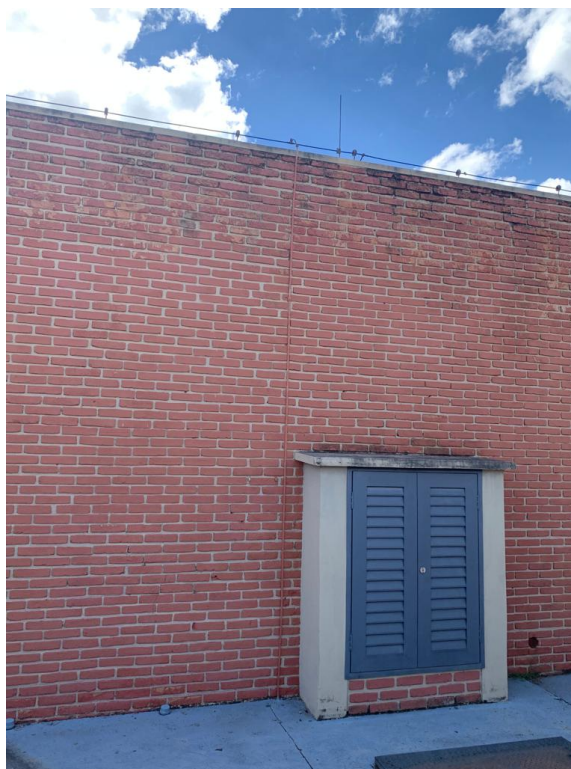
Figura 37 – Descida do para-raio
