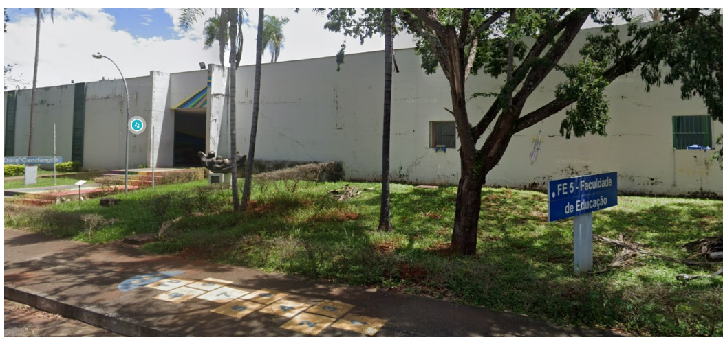
Figura 14 – Fachada do prédio FE5
