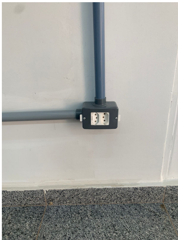
Figura 23 – Tomada de uso geral.
