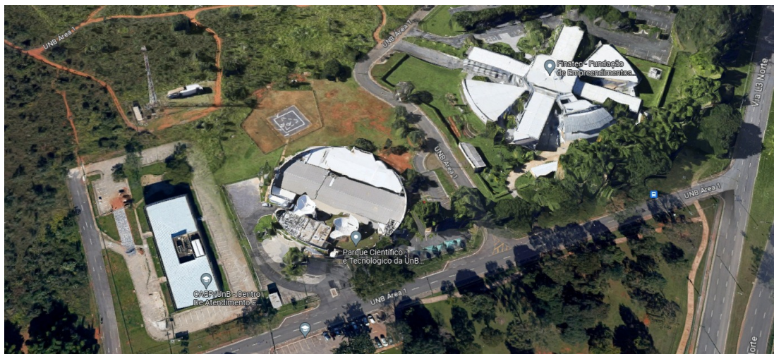
Figura 11 – Vista superior do prédio PCTec
