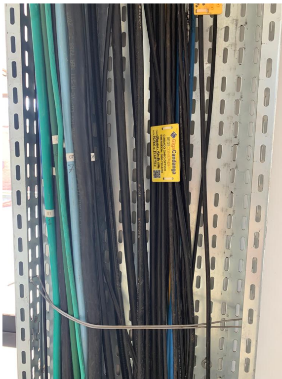
Figura 35 – Disposição dos cabos na eletrocalha
