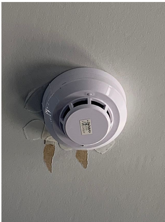
Figura 43 – Detector de fumaça
