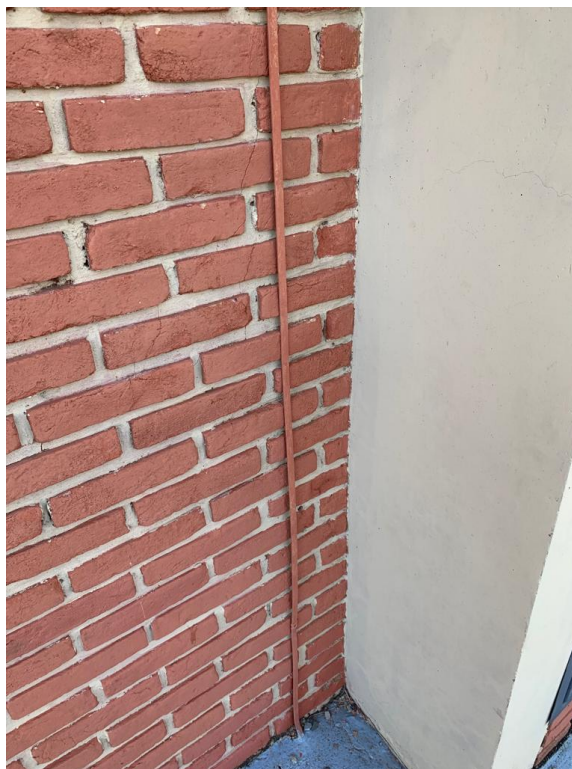
Figura 38 – Descida do para-raio
