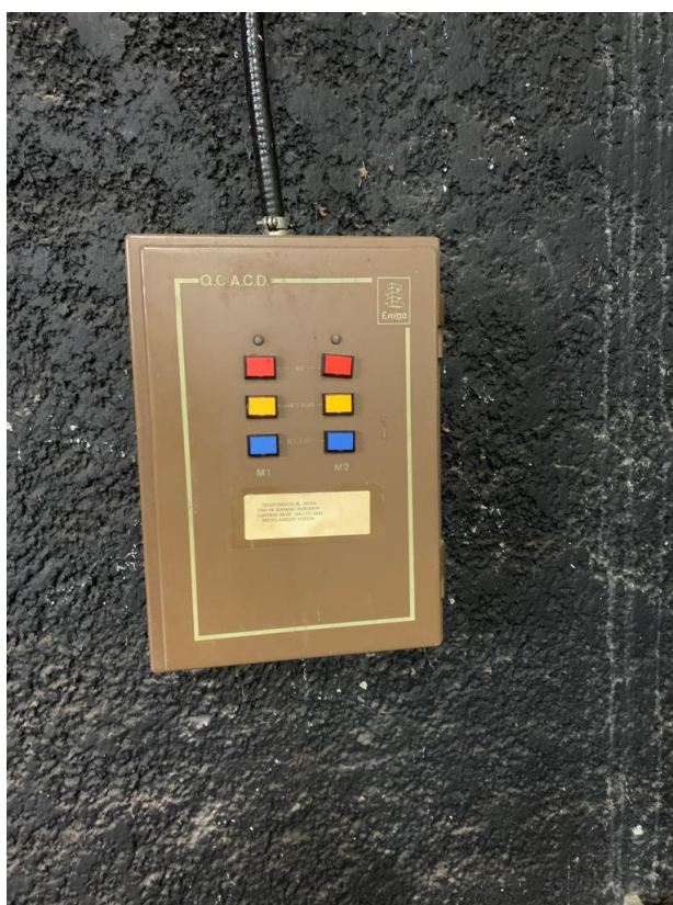
Figura 58 – Porta do quadro 2 do auditório
