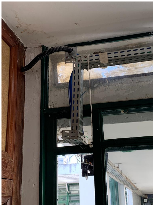
Figura 63 – Eletrocalha
