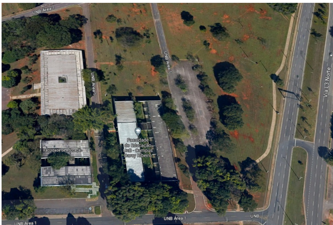
Figura 13 – Vista superior do prédio FE5
