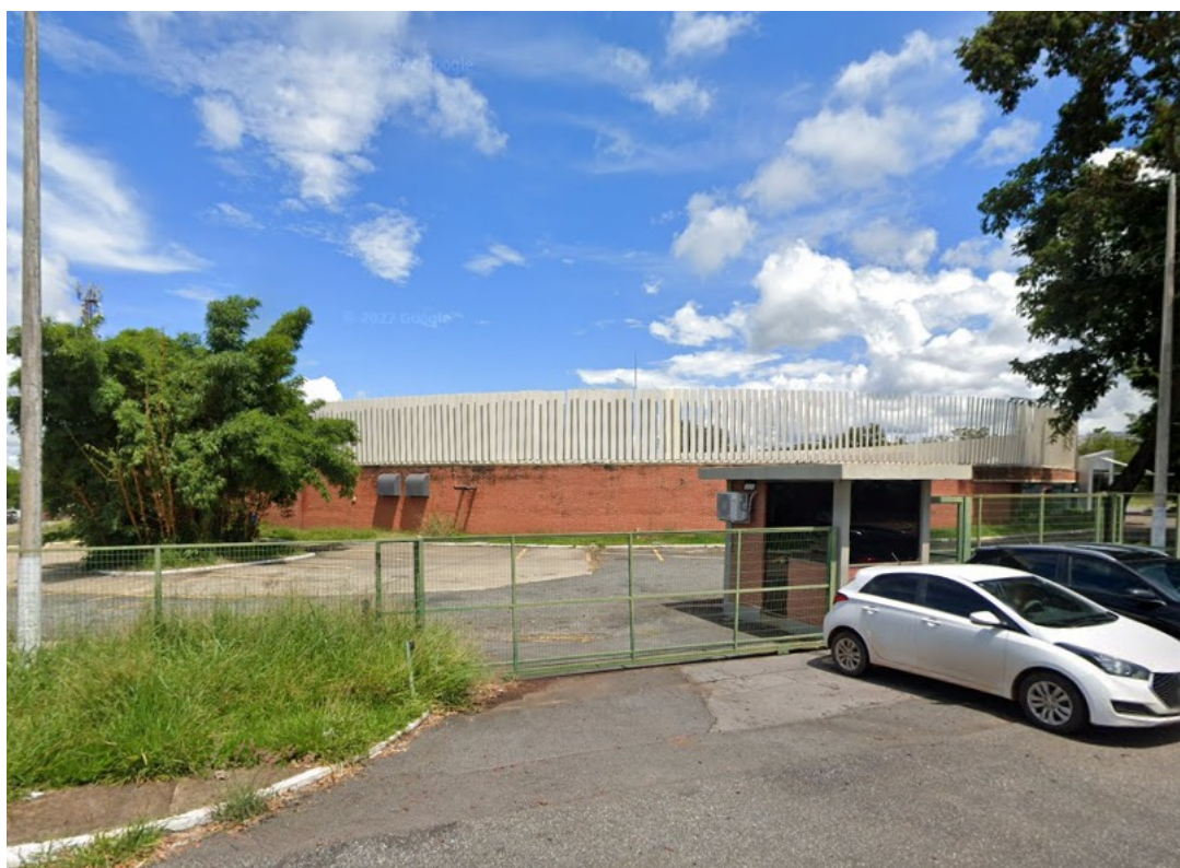
Figura 12 – Fachada do prédio PCTec
