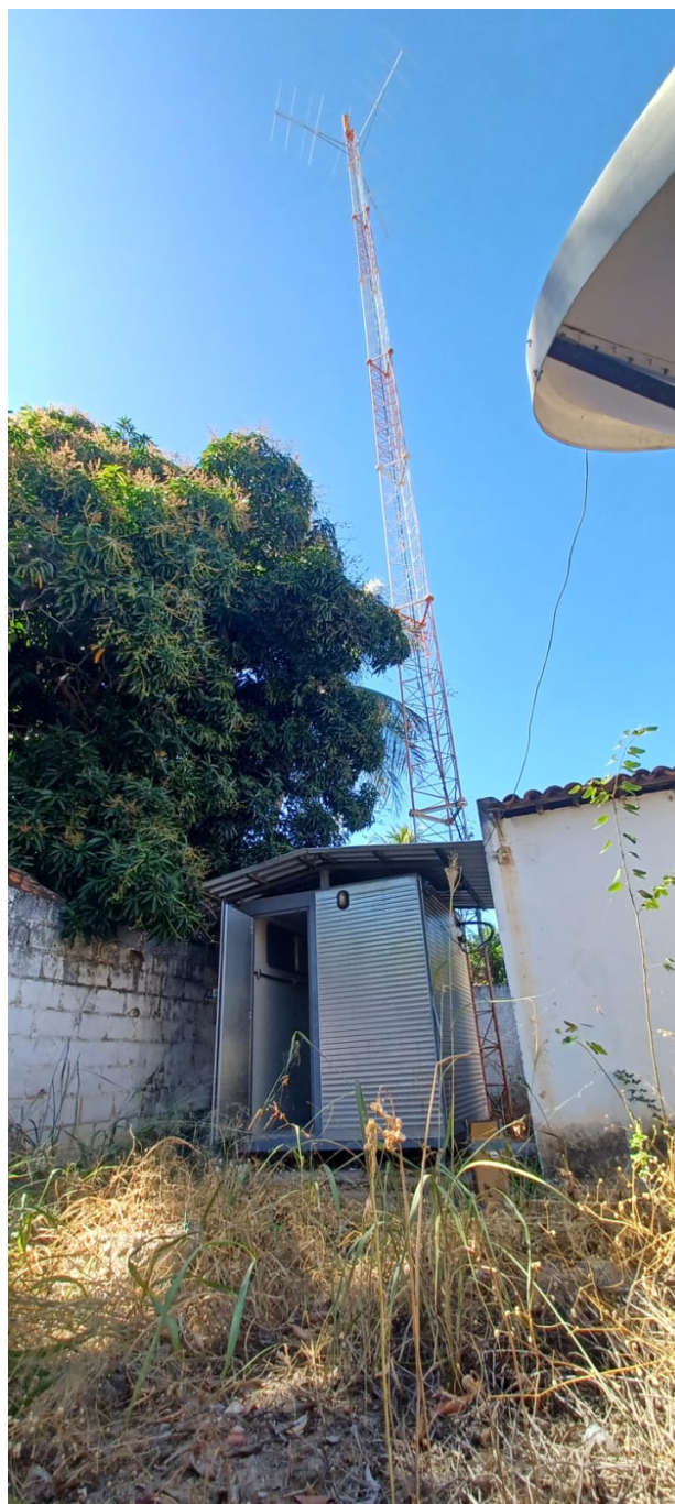
Figura 14 – Exterior do abrigo.
