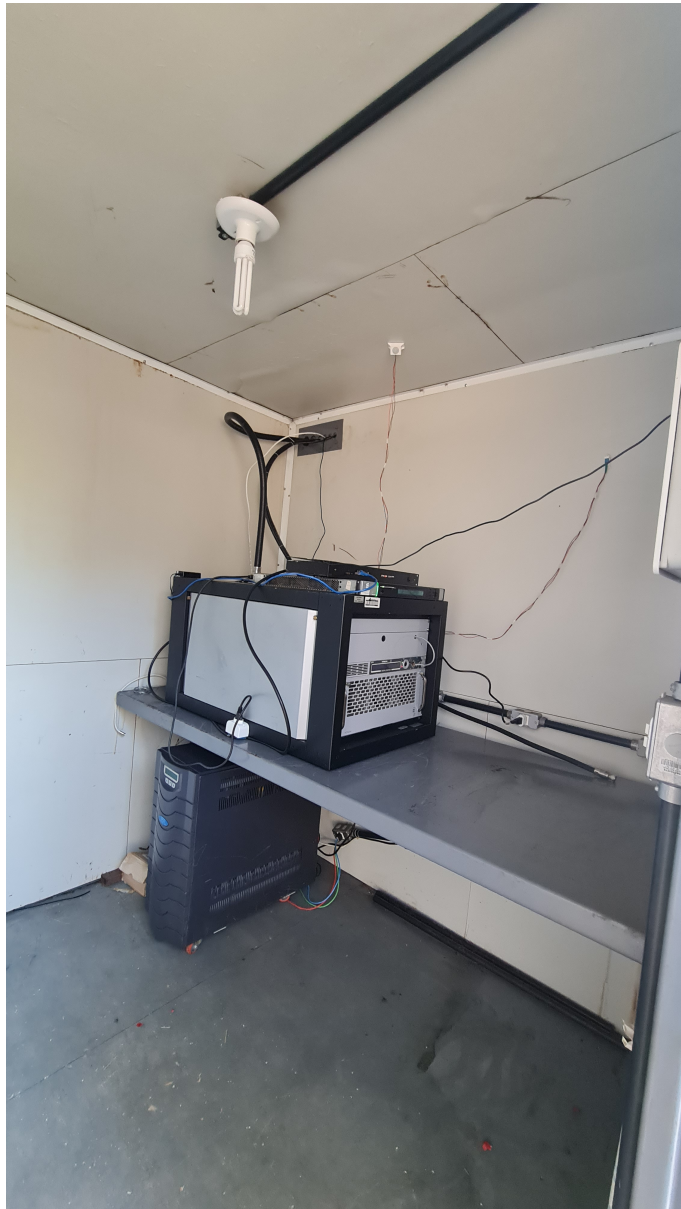
Figura 15 – Interior do abrigo.
