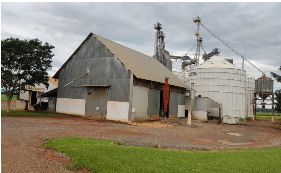
Figura 18. Moega e Silos de armazenamento (AVILA, 2022)
