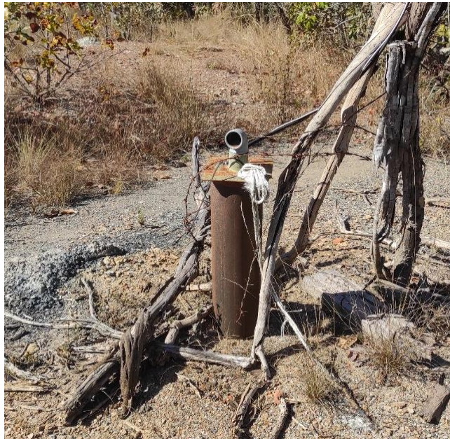
Figura 6.3 - Poço tubular sem cimentação inativado, provavelmente porque possuía baixa vazão ou água de qualidade indesejada. Localizado na subárea XIV, não cadastrado no Sistema de Informações de Águas Subterrâneas.
