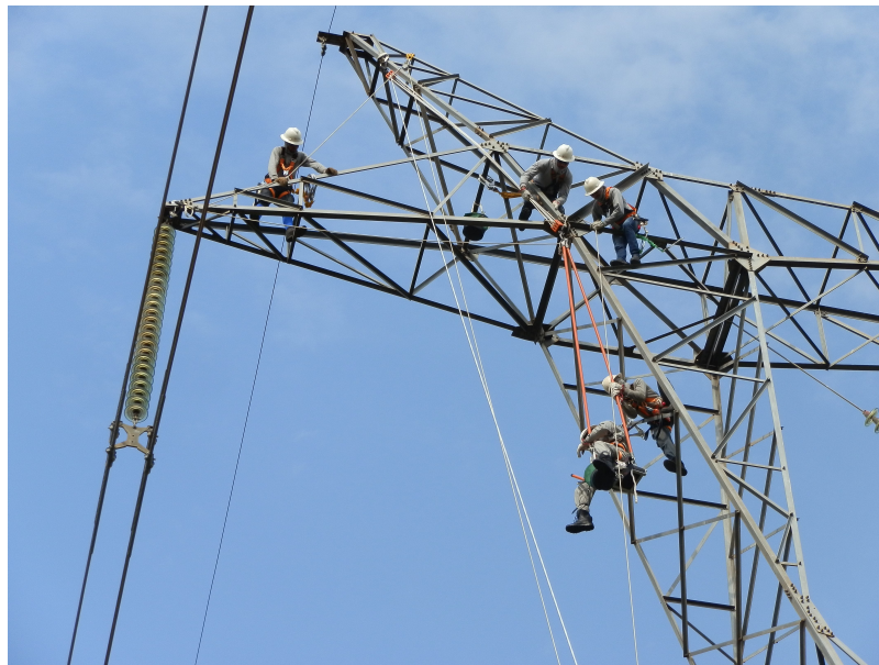
Figura 1.2 – Manutenção em linha de transmissão energizada (MEDRAL, 2022).
