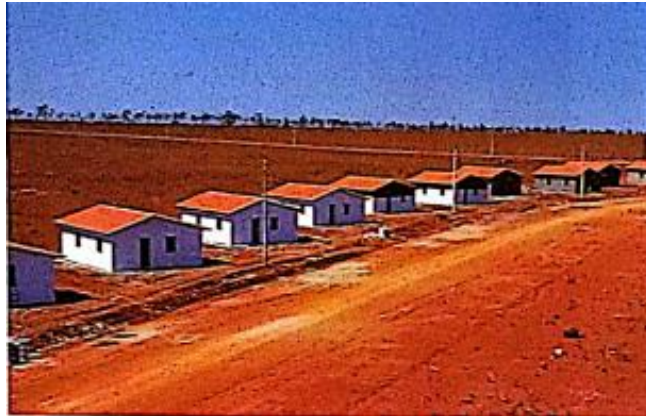
Figura 7: Imagem aérea de algumas casas do CAUB I (BRASÍLIA, 1987a, p. 13).
