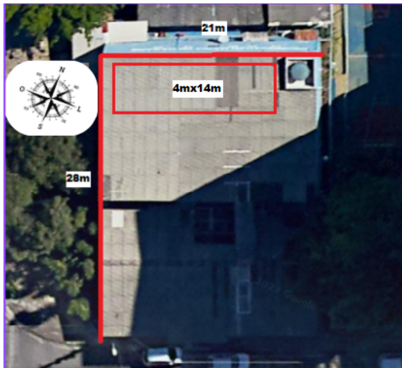
Figura 3 – Telhado da Creche Maria de Nazaré.
