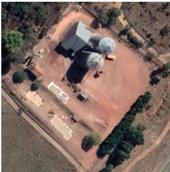
Figura 16- Vista de cima do local da Instalação
