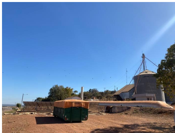
Figura 17- Vista lateral do local da Instalação
