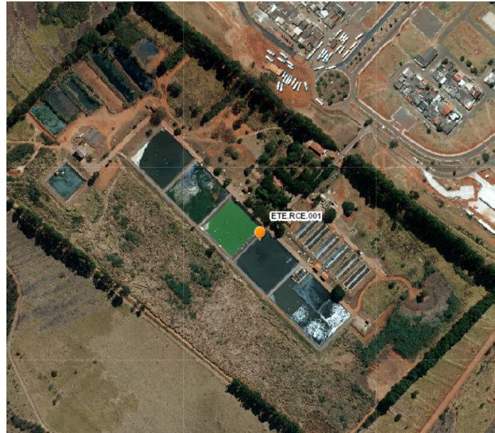
Figura 25 – ETE Recanto das Emas.
