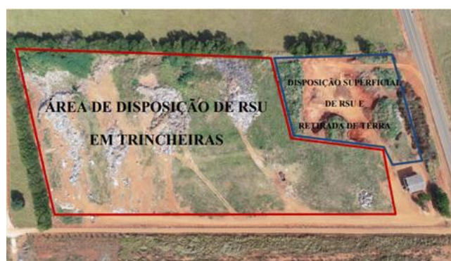
Figura 5.17 – Divisão das áreas de confinamento do RSU do lixão de Firminópolis-Go (PRAD – Prefeitura municipal de Firminópolis, 2018)
