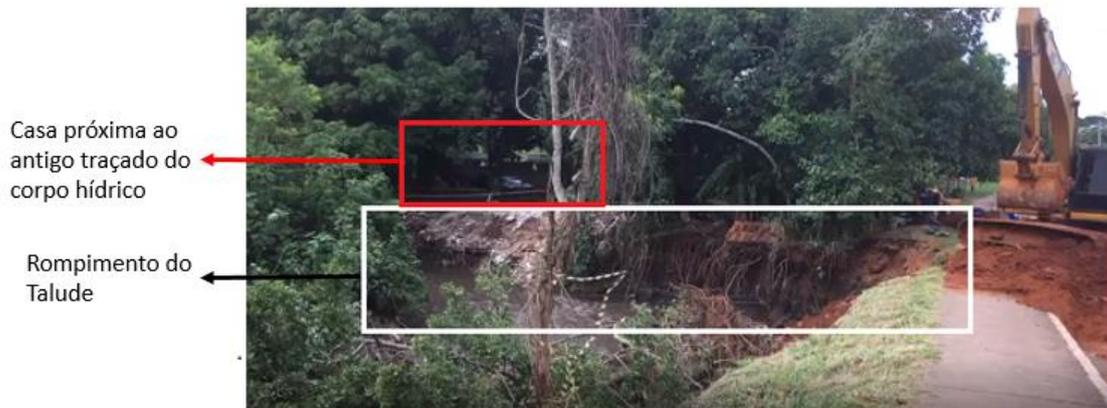
Figura 22 - Registro fotográfico do rompimento do talude. (Agência Brasília, 2019)
