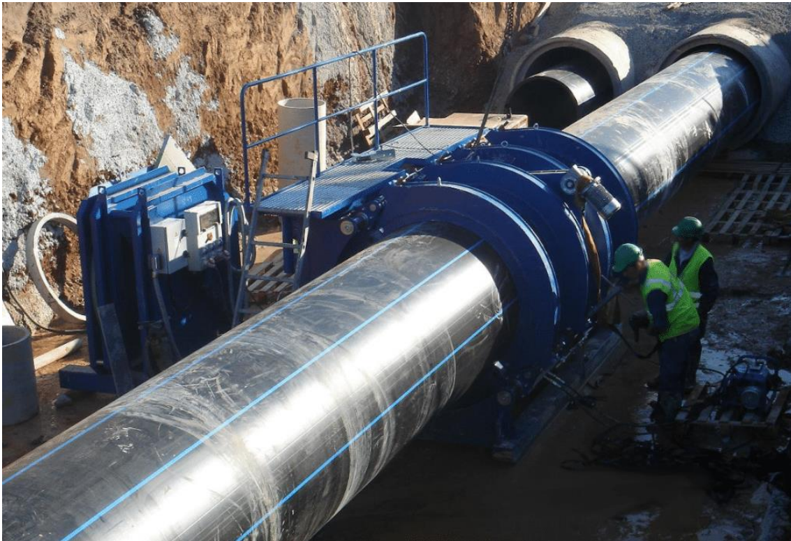
Figura 1.4 Tubos de PEAD utilizados num sistema de distribuição de água. Fonte: parsethylene-kish. Disponível em: https://www.parsethylene-kish.com/ . Acesso em: 14/09/2022.
