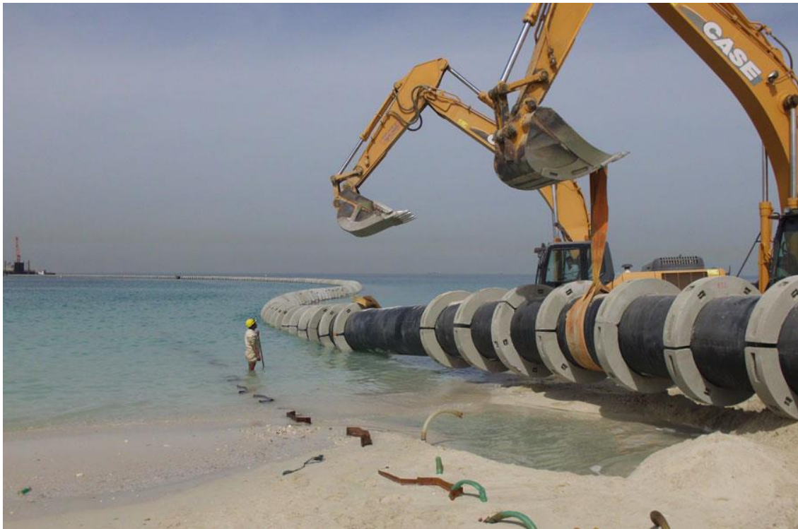
Figura 1.3 Instalação de tubos de PEAD utilizada em um processo de dessalinização. Fonte: Union Dredgers. Disponível em: https://uniondredgers.com/offshore-pipeline-installation-projects/ . Acesso em: 10/08/2022.
