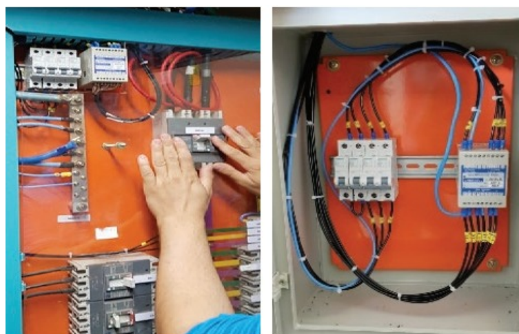
Figura 14 – Exemplo de instalação dos medidores no Campus Darcy Ribeiro. (REIS et al., 2020)
