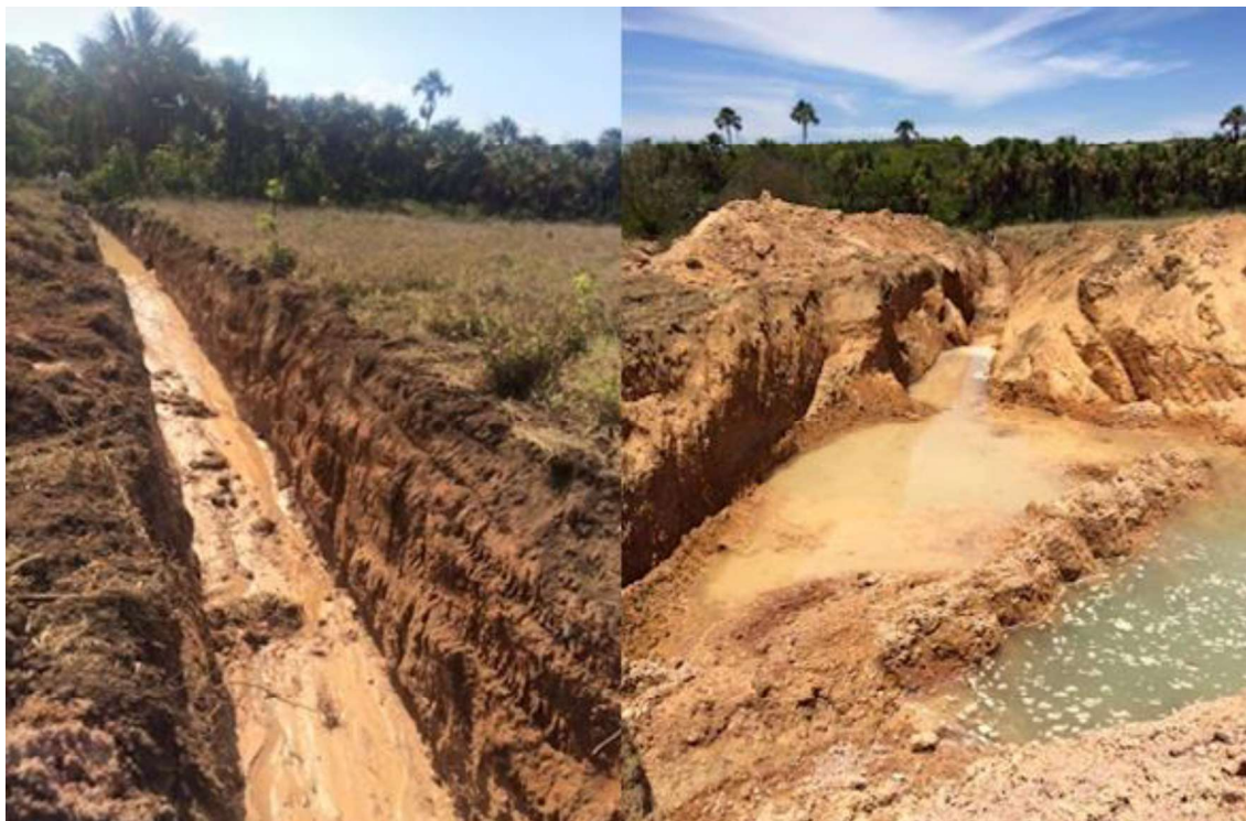
Figura 8 – Carreamento de sedimentos decorrentes da mineração em Planaltina-GO.
