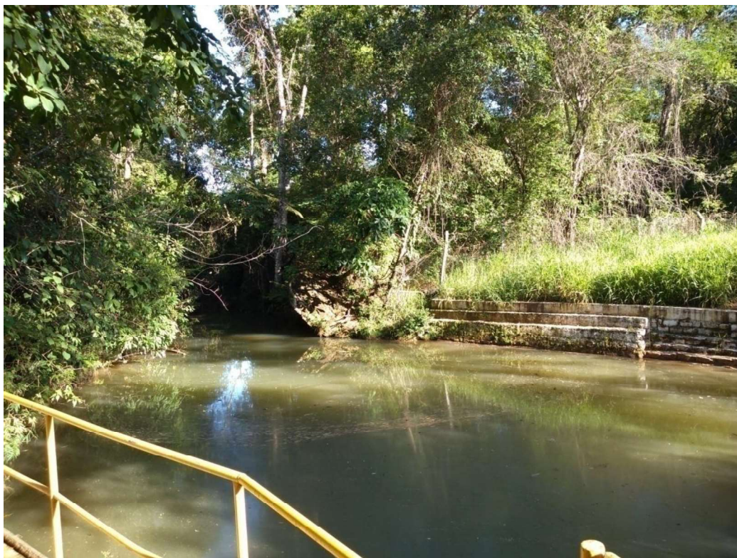
Figura 4 – Local da captação do rio Maranhão no mês seco – Notar água com aspectos de baixa turbidez.
