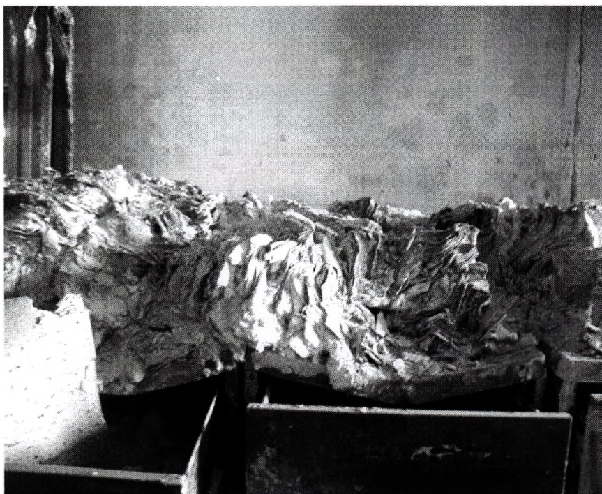
Figura 13 - Restos de material danificado durante o ataque
