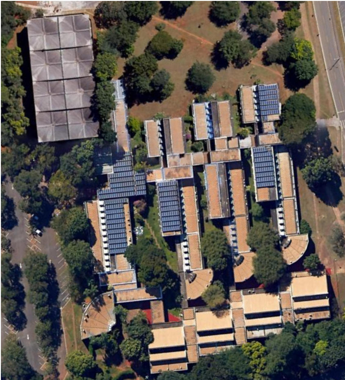
Figura 4 - Edifício da Faculdade de Tecnologia
