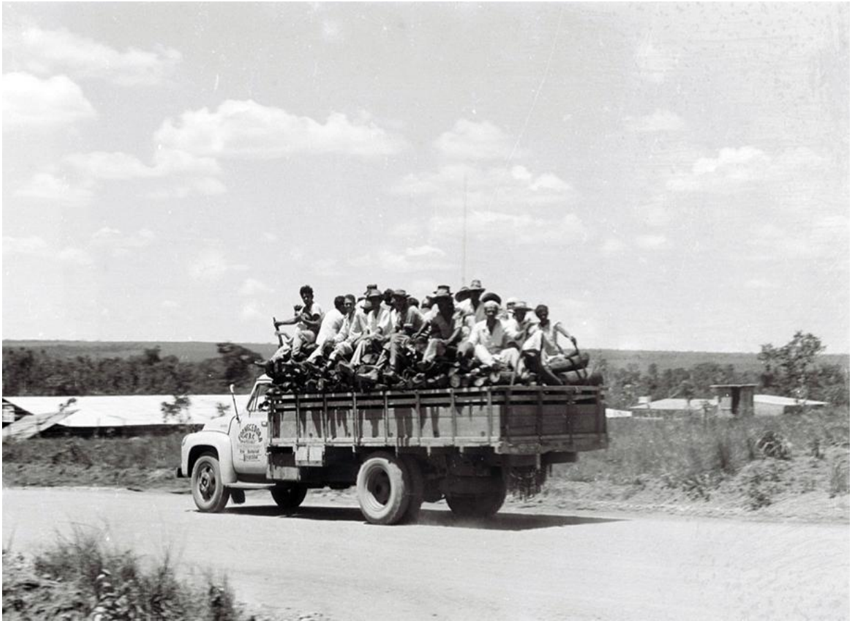
Figura 3 — “Arpdf/Caminhão transporta operários para obra Fundo Novacap – Arquivo Público do DF (8)”
