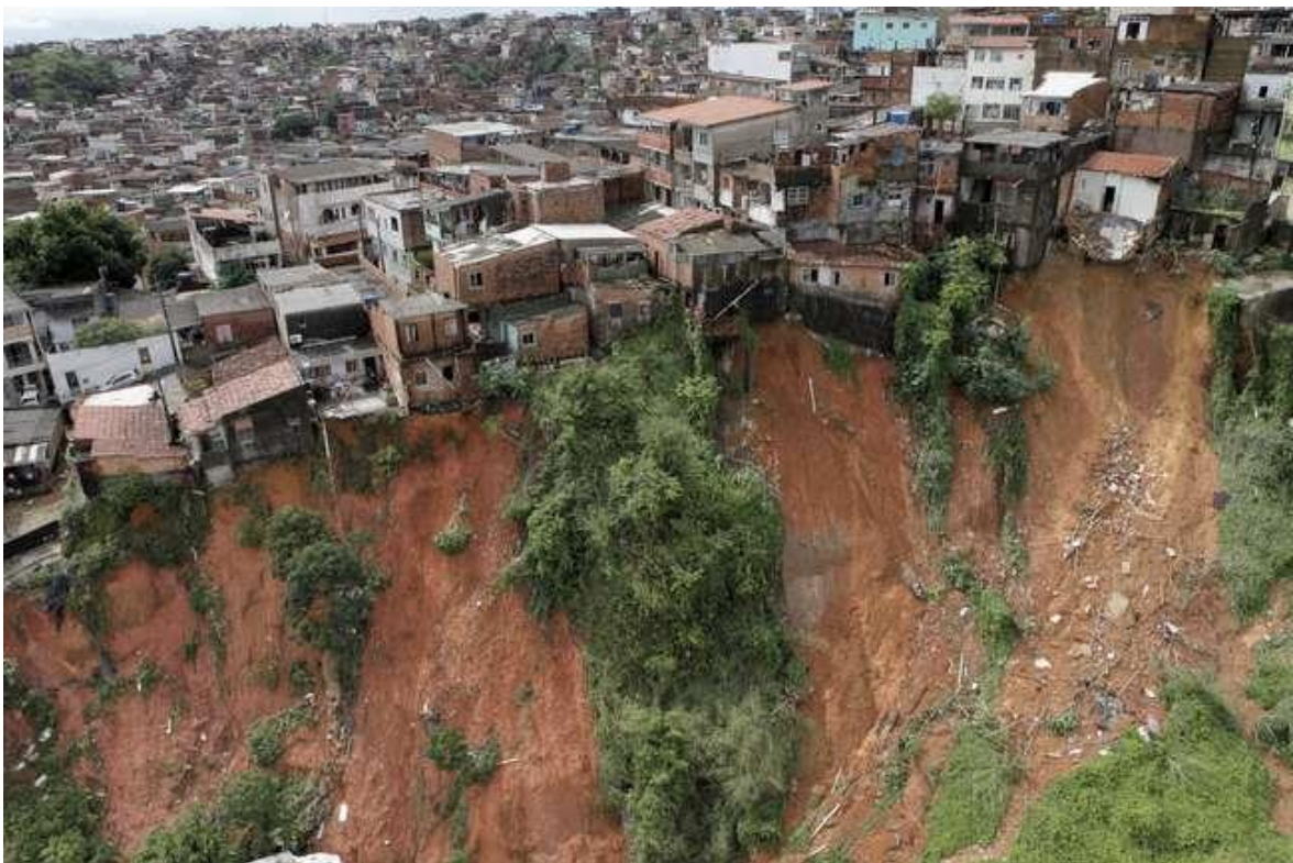
Figura 2 – Deslizamento de terra ocasionado por eventos naturais em conjunto com ação antrópica no estado de Salvador. Fonte: Dias, 2015.
