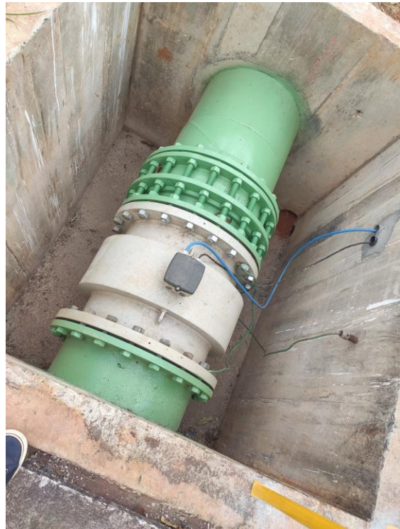
Figura 4.4 – Chegada da adutora por gravidade. (a): entrada na EEAT; (b): medição de vazão
