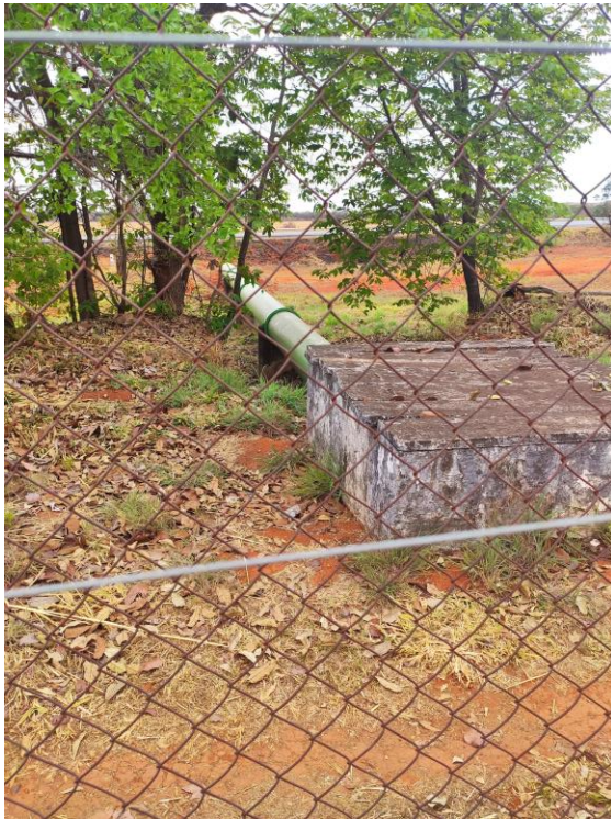
Figura 4.4 – Chegada da adutora por gravidade. (a): entrada na EEAT; (b): medição de vazão
