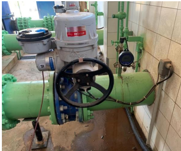
Ponto C – Recalque (jusante da VR)
