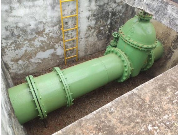
Figura 4.14 – Linha de recalque. (a): saída da EEAT; (b): entrada no RAP; (c): válvula de bloqueio na entrada do RAP; (d): ramificação da entrada – tubulações na extrema direita e esquerda da foto
