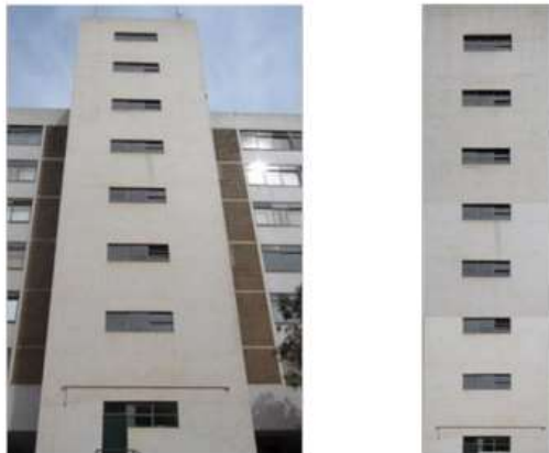
Figura 3.4 – Fachada geral e foto da fachada ortogonalizada. Fonte: Souza e Bauer, 2020.
