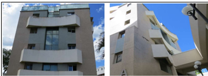
Figura 3.2 – Empena do edifício A. Fonte: Autor.
