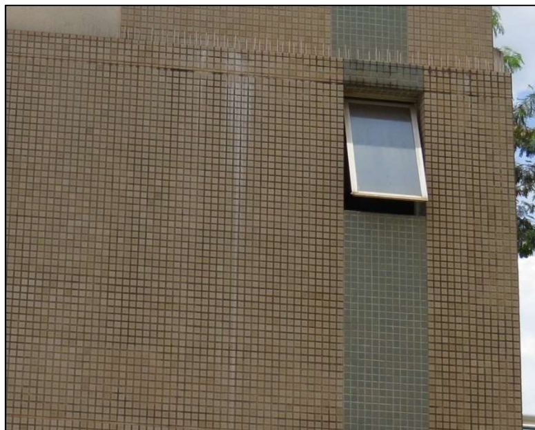
Figura 2.8 – Eflorescência em paredes contínuas. Fonte: Autor.
