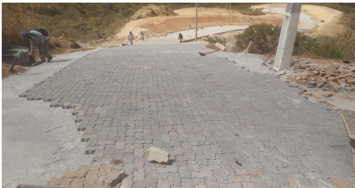
Figura 4.8- Execução do pavimento com piso intertravado
