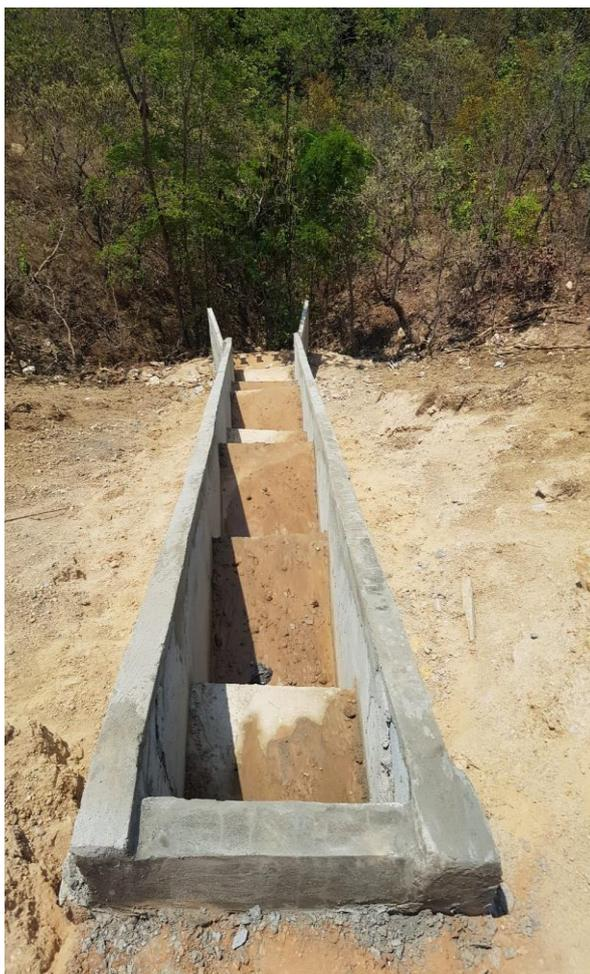
Figura 4.7- Construção da escada hidráulica para drenagem
