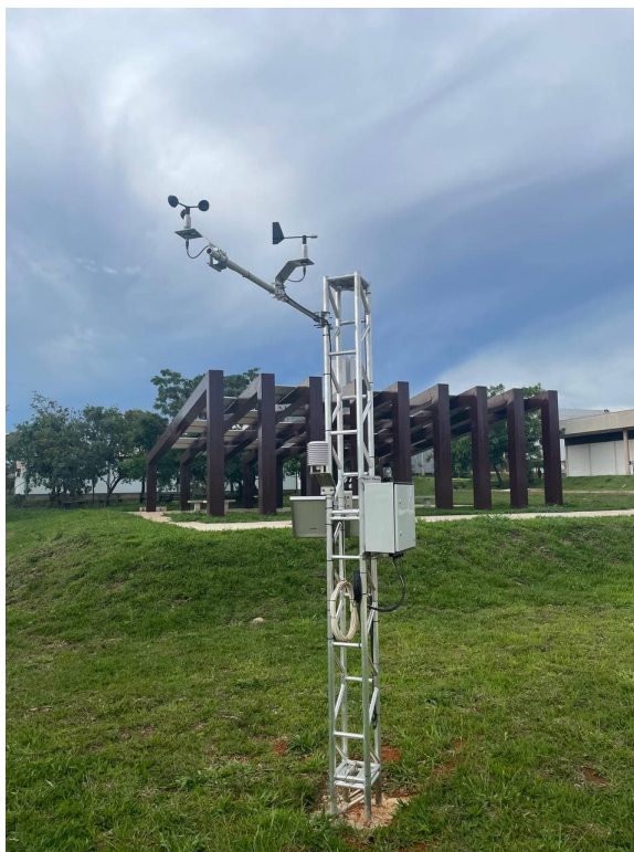
Figura 3 – Estação Solarimétrica Instalada na FGA.
