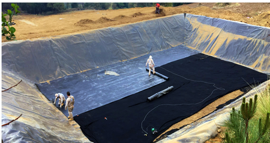
Figura 17 – Impermeabilização de biodigestor. Fonte: Total (2022).
