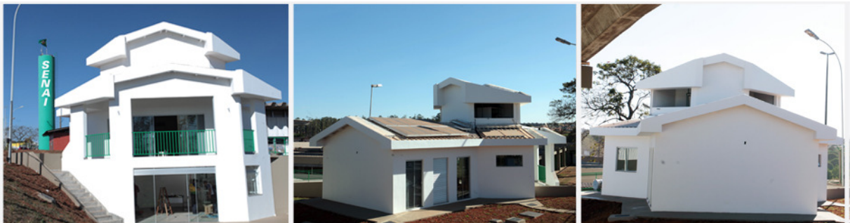
Figura nº 3 – Casa Solar Taguatinga - DF.
