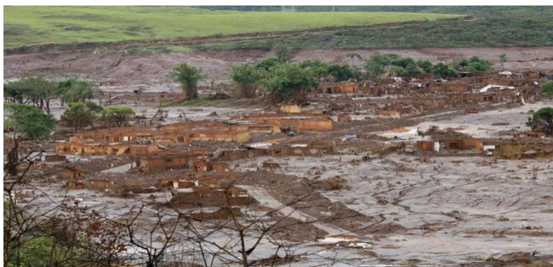
Figura 13 – Bento Rodrigues, a primeira a ser atingida pela lama – Rompimento da Barragem do Fundão - 2015
