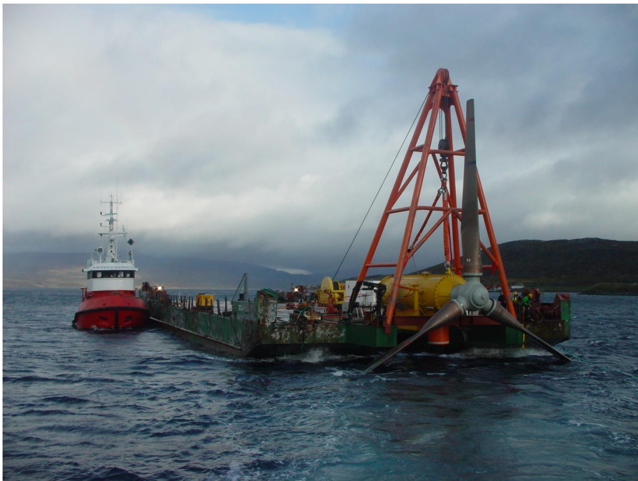
Figura 5. Instalação do HS300 da Hammerfast-Strom. Fonte: SPR, 2015.
