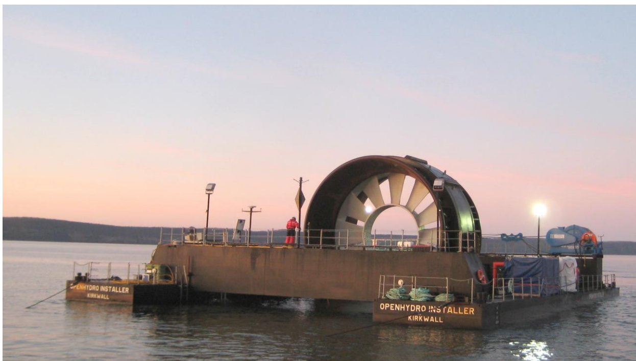
Figura 9. Turbina Open Center sendo instalada em Bay of Fund na Nova Escócia. Fonte: DCNS, 2015.
