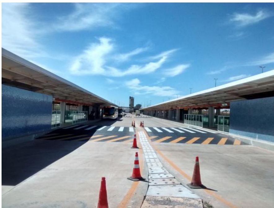
Figura 3.11 - Visão Central do Terminal
