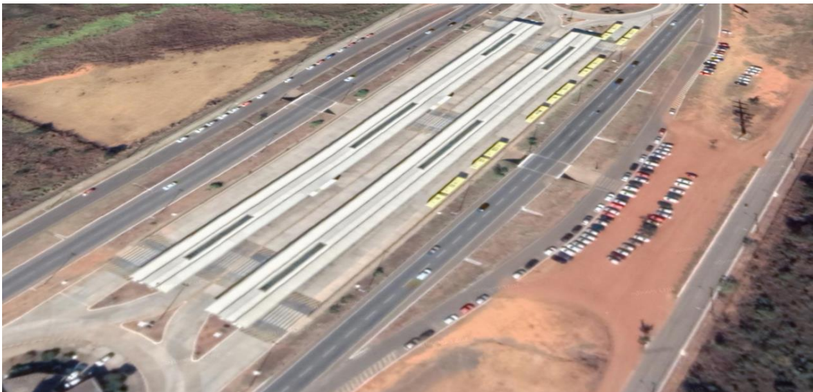
Figura 3.6 - Vista superior - Terminal de BRT do Gama
