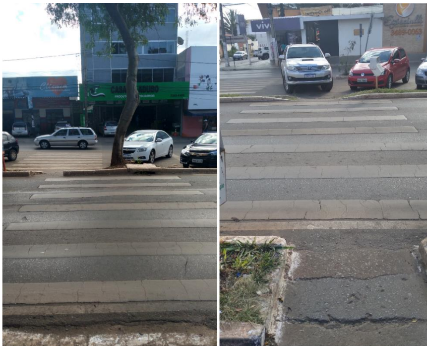
Figura 4-21. Faixa de pedestre termina no meio-fio e está desalinhada em relação à travessia do outro lado da via (à esquerda); e veículo obstruindo a saída da faixa e travessia desalinhada (à direita). Fonte: Elaboração dos autores.
