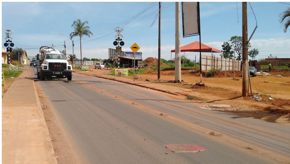
Figura 3.2 – Vista do arco 1 direcionada para a rótula
