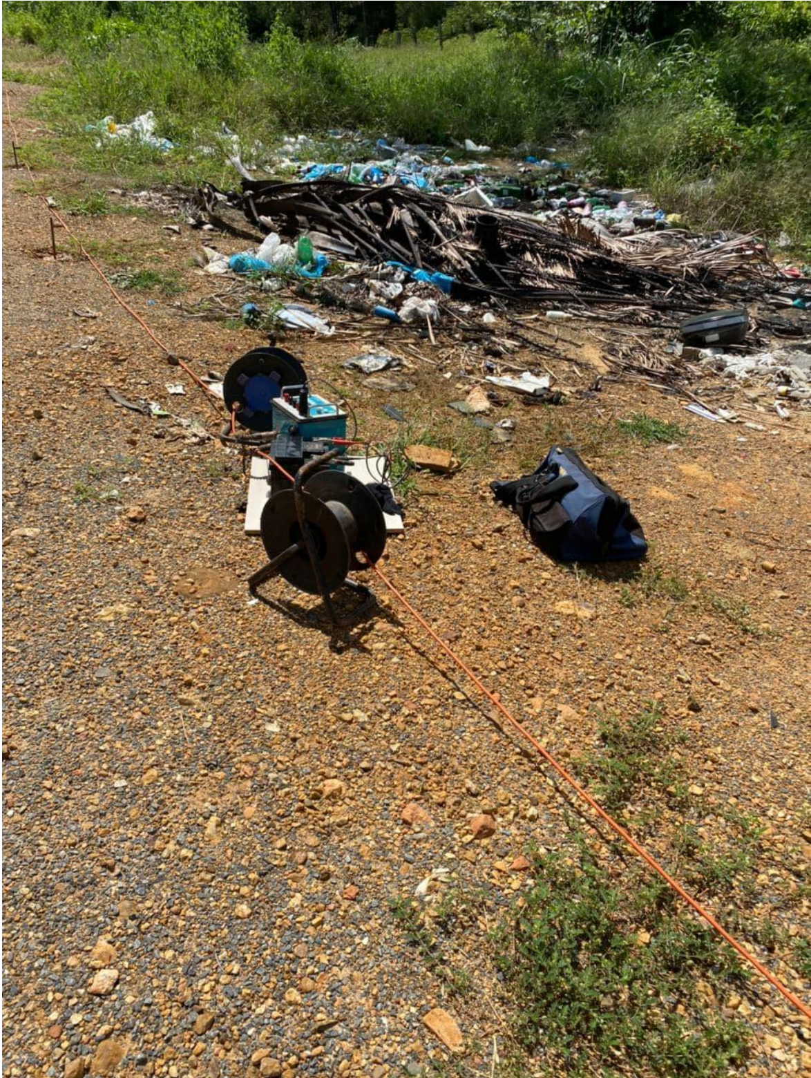
Figura 6. 14 - Equipamento em operação para a verificação da Linha 2.
