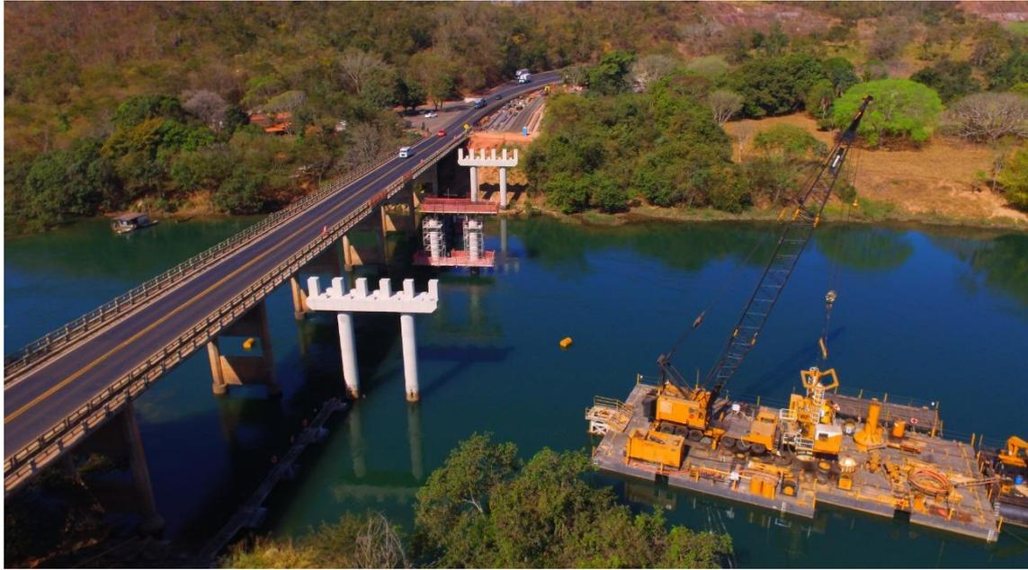
**Figura 23 – Pilares da ponte e o veículo de apoio náutico**
