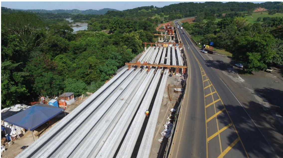
**Figura 26 – Vigas pré-moldadas**
