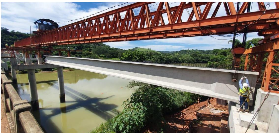
**Figura 25 – Lançamento das vigas com a treliça lançadeira**
