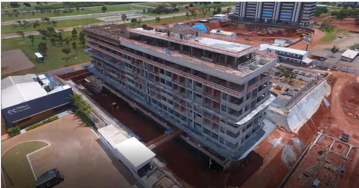
**Figura 11 – Visão frontal do edifício com a grande escavação**
