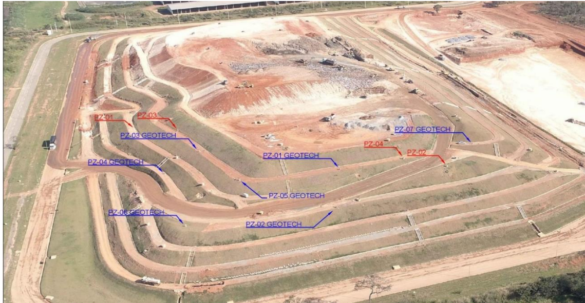
Figura 3.1 – Vista aérea do Aterro Sanitário de Brasília (ASB).
